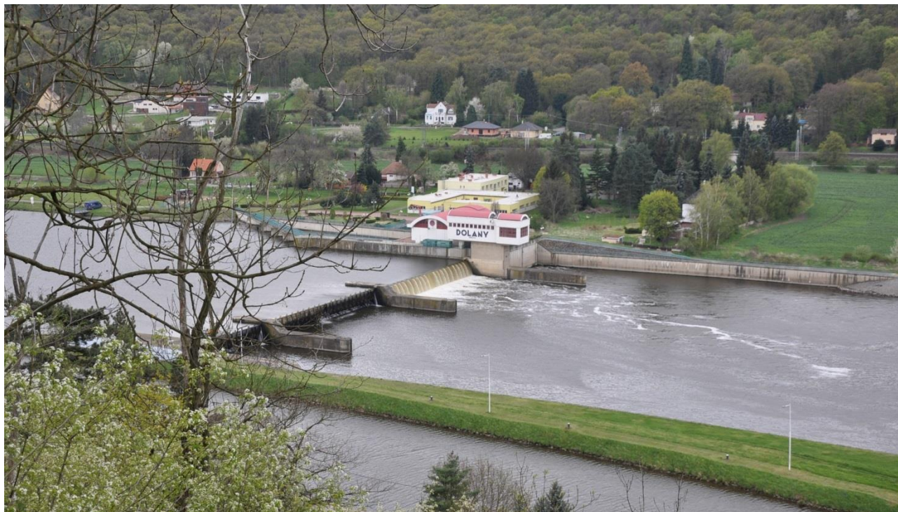
Obrázek 13: Zdymadlo Dolany na Vltavě s vodní elektrárnou a obtočným korytem
