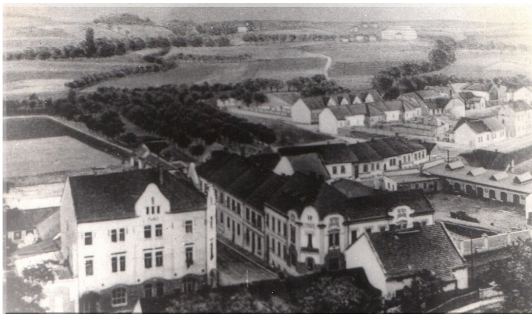
Hotel "Slavie" v Přemyslově ulici. Rohová budova vlevo.
